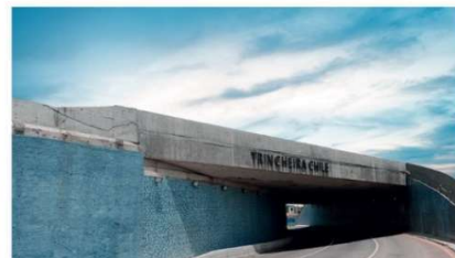
Trincheira Chile EVEHX Curitiba - PR
