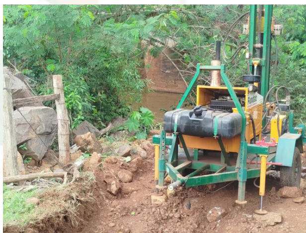
Imagem 01: Local de execução do SR-1 e SR-2.
